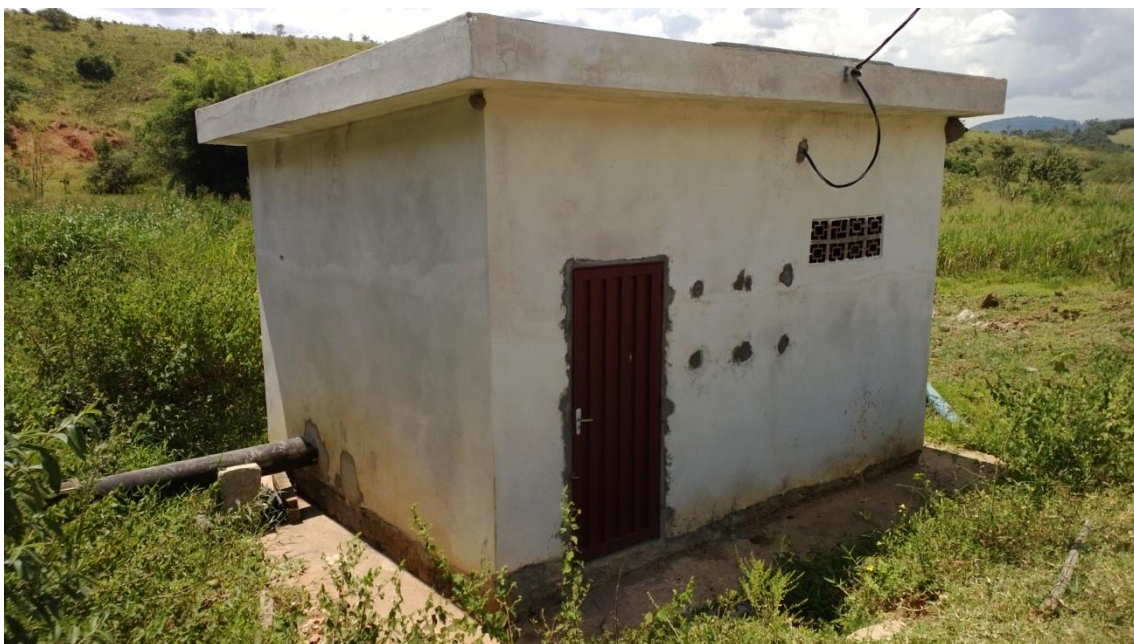
Figura 3.12 – Casa de bomba – Água Espalhada.
