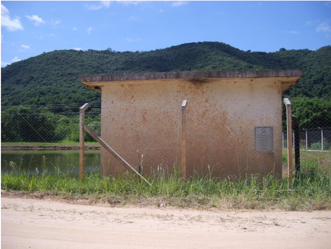
Figura 3.6 – Reservatório e casa de bomba – captação Anésio Folgati.
