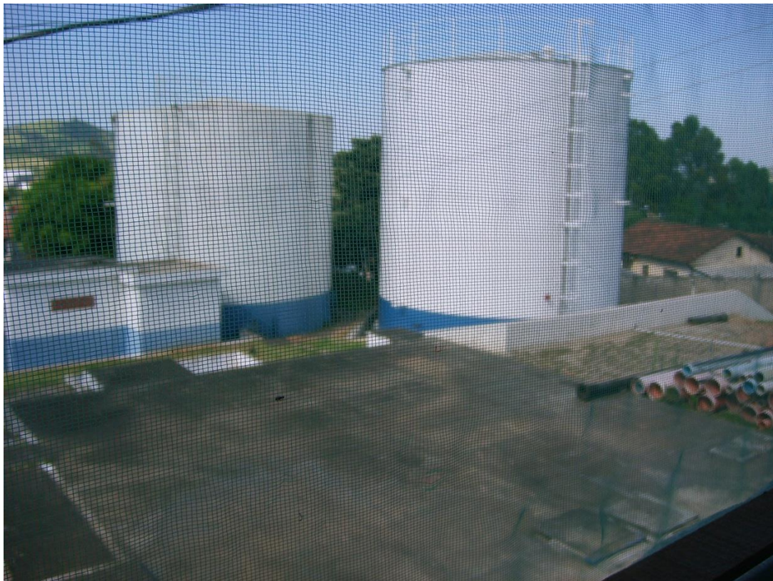
Figura 3.21 – Reservatório localizados na ETA principal
