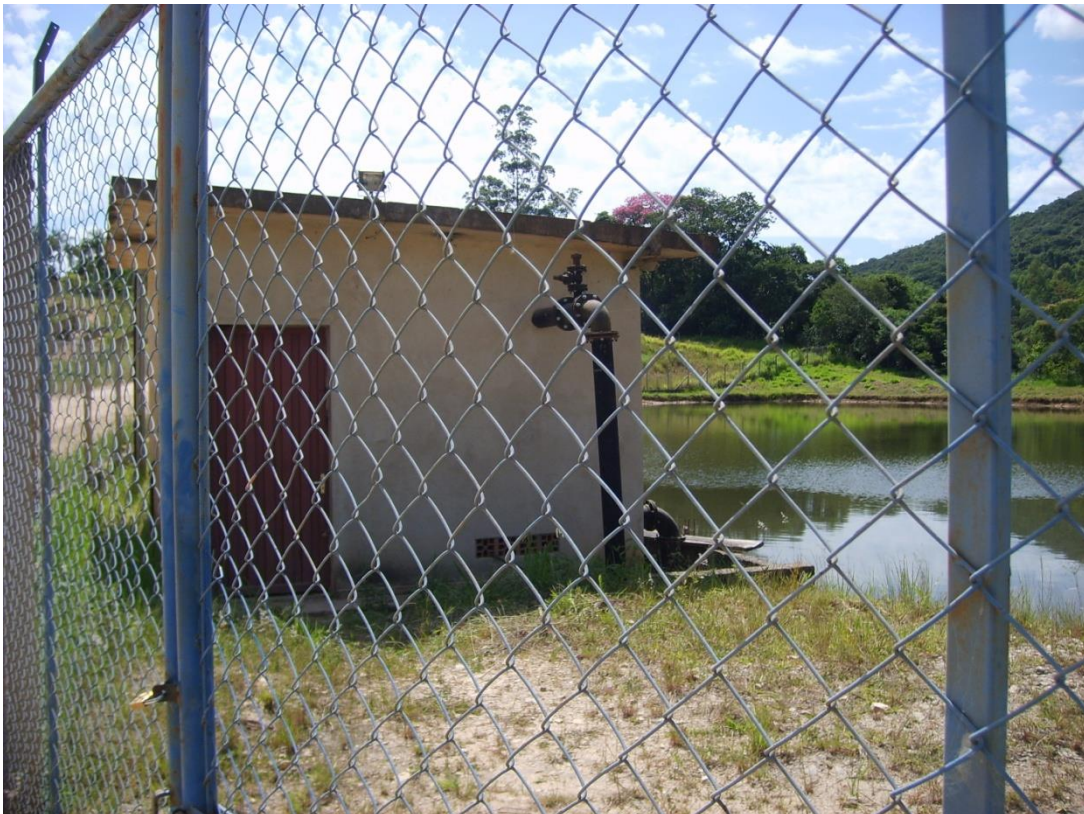
Figura 3.7 – Casa de bomba – captação Anésio Folgati.
