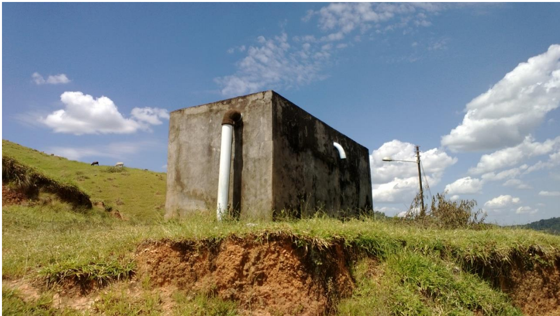
Figura 3.24 – Reservatório 04 (à dir.) e Reservatório 05 (à esq.)
