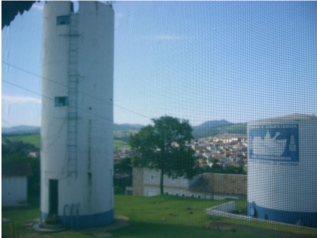
Figura 3.22 – Reservatórios localizados na ETA principal
