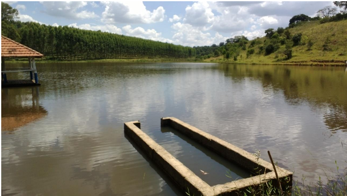
Figura 3.11 – Captação – Água Espalhada.
