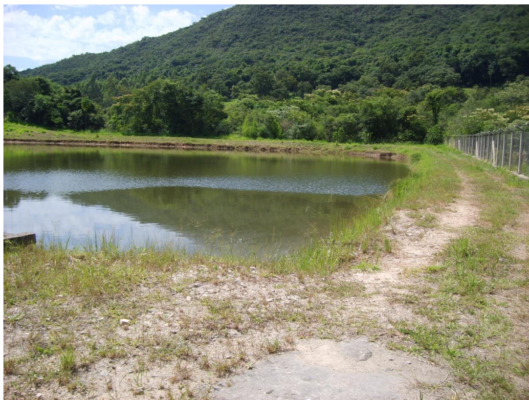
Figura 3.5 – Reservatório da captação Anésio Folgati.
