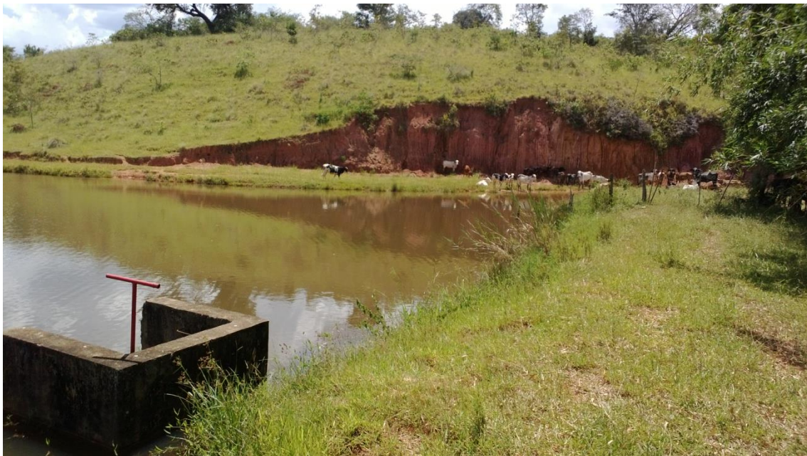
Figura 3.10 – Presença de rebanho bovino no reservatório de Água Espalhada.
